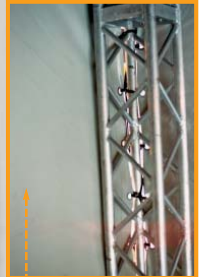
Innenansicht der Eckverbindung
