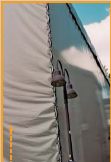
Aussenansicht der Eckverbindung
